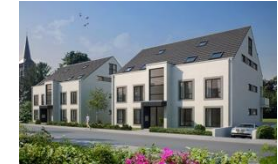
BV Böcklerstraße, Leverkusen - Opladen
