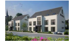
BV Böcklerstraße, Leverkusen – Opladen
